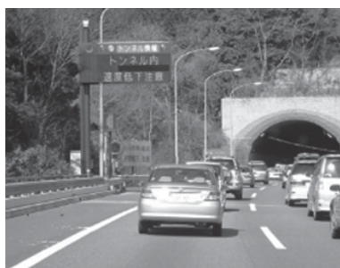
上り線小仏トンネル付近渋滞状況
